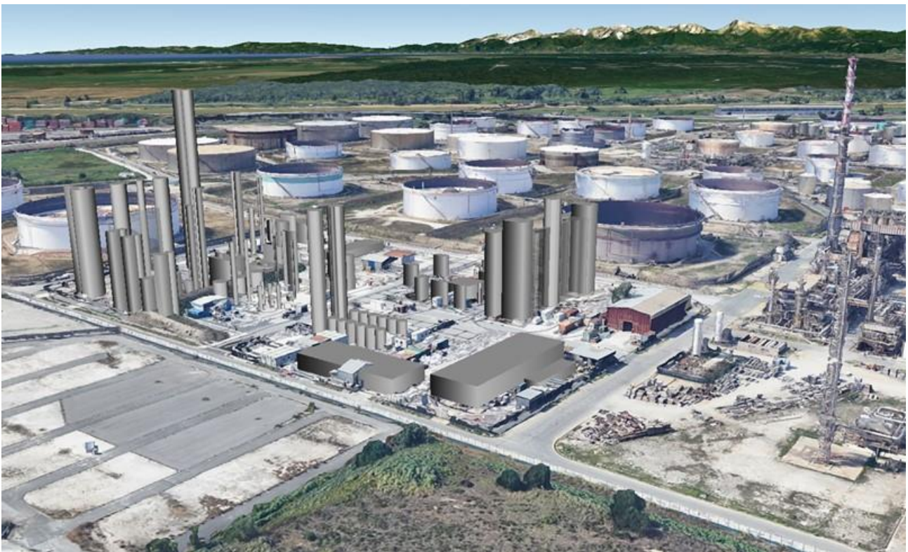
Figura 7.5 - Vista da Sud Est sull'unità strutturale Ecofining™. Si evidenzia l'indifferenza rispetto ai caratteri morfologici del paesaggio
