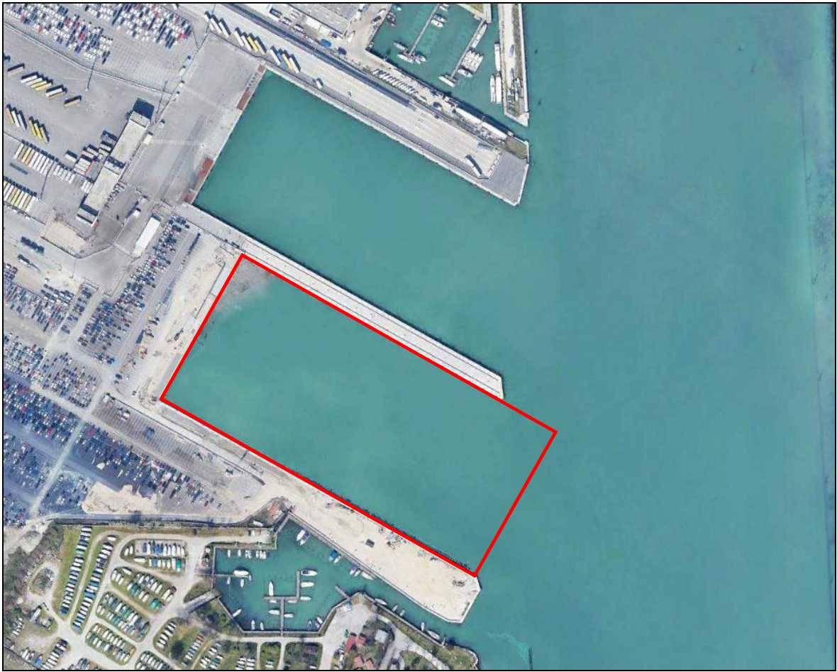
Figura 1-1 Ubicazione dell'area di escavazione.
