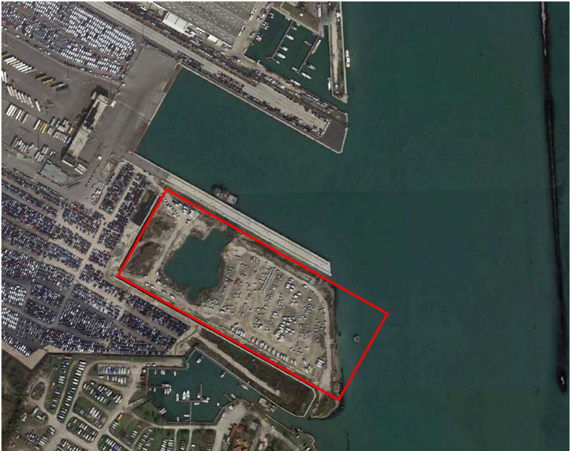
Figura 1-1 Ubicazione dell'area di escavazione.
