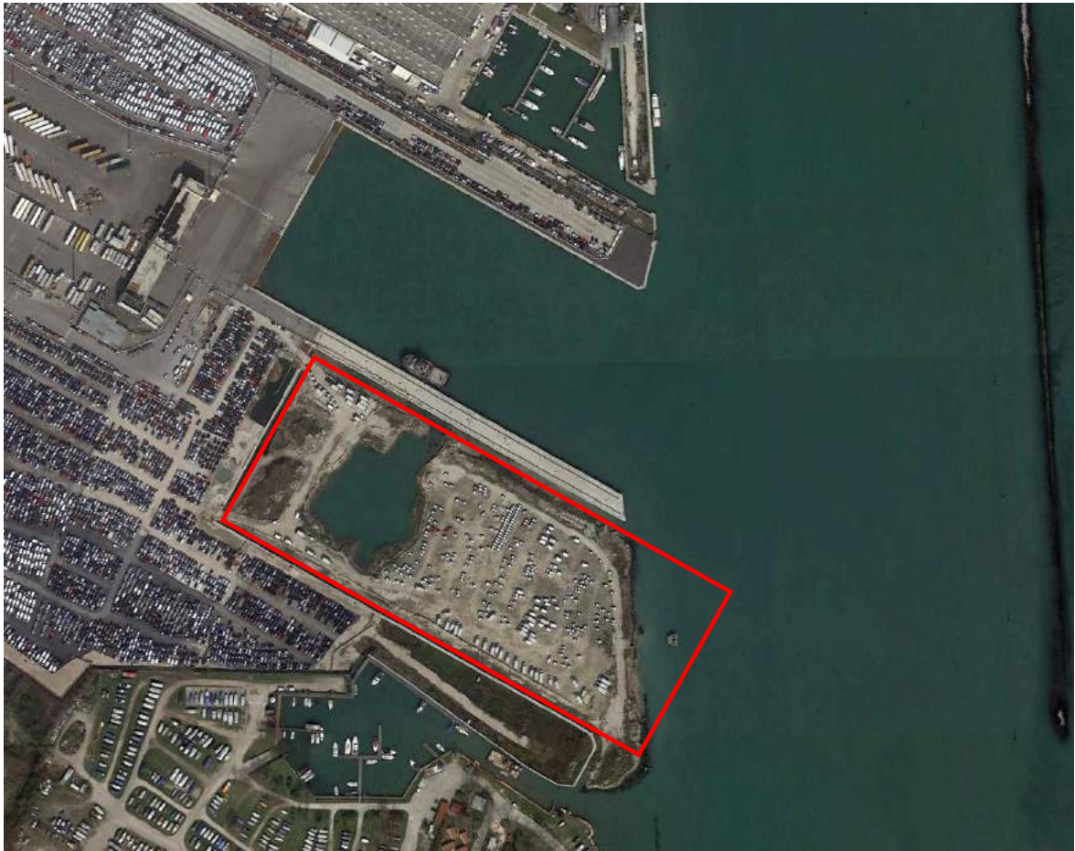
Figura 1-1 Ubicazione dell'area di escavazione.
