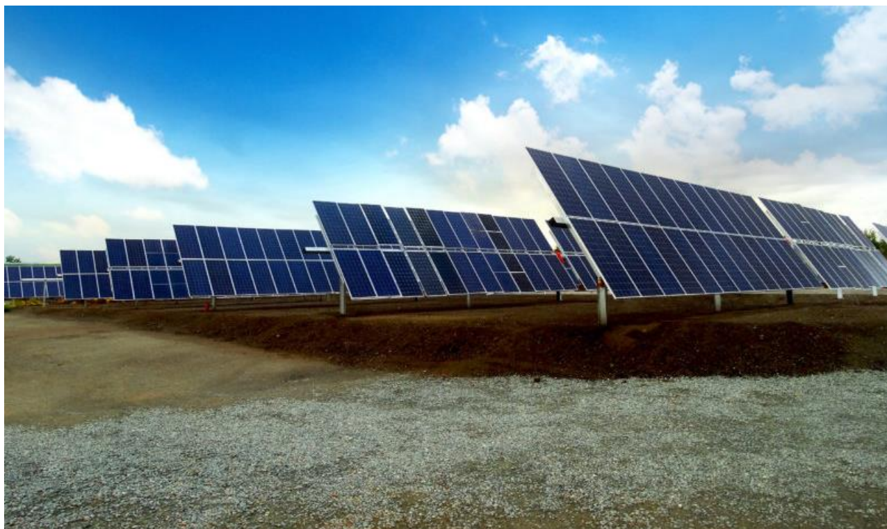
Figura 1 - immagine esemplificativa di inseguitori mono-assiali in configurazione 2P (fonte: Soltec)
