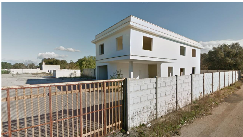
Fig. 4.2a Edificio a nord-est dell'area di intervento
