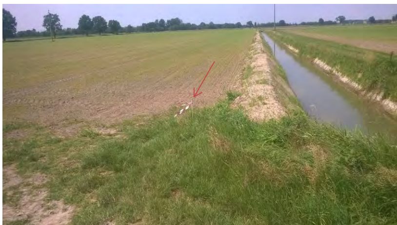
Figura 2: roggia lungo il confine est della lottizzazione vista da sud, in corrispondenza del punto di prova CPT 2 e piezometro Pz 2 (freccia)
