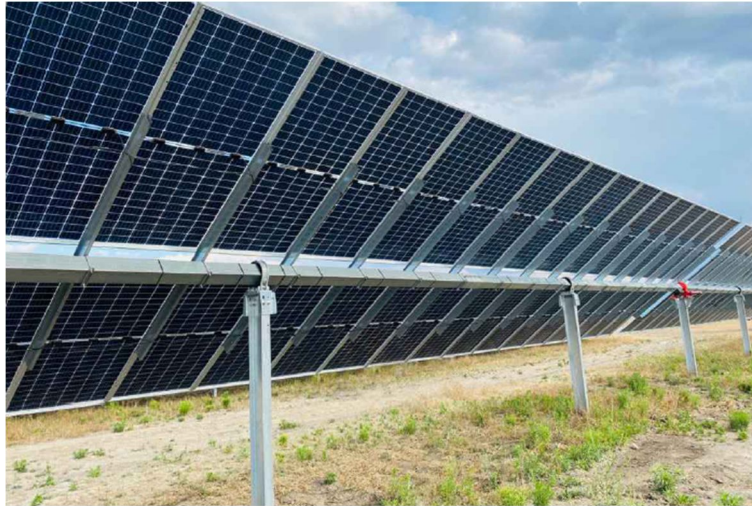
(Esempio di tracker monoassiale montante moduli bifacciali; in rosso si scorge il motore per la rotazione)
