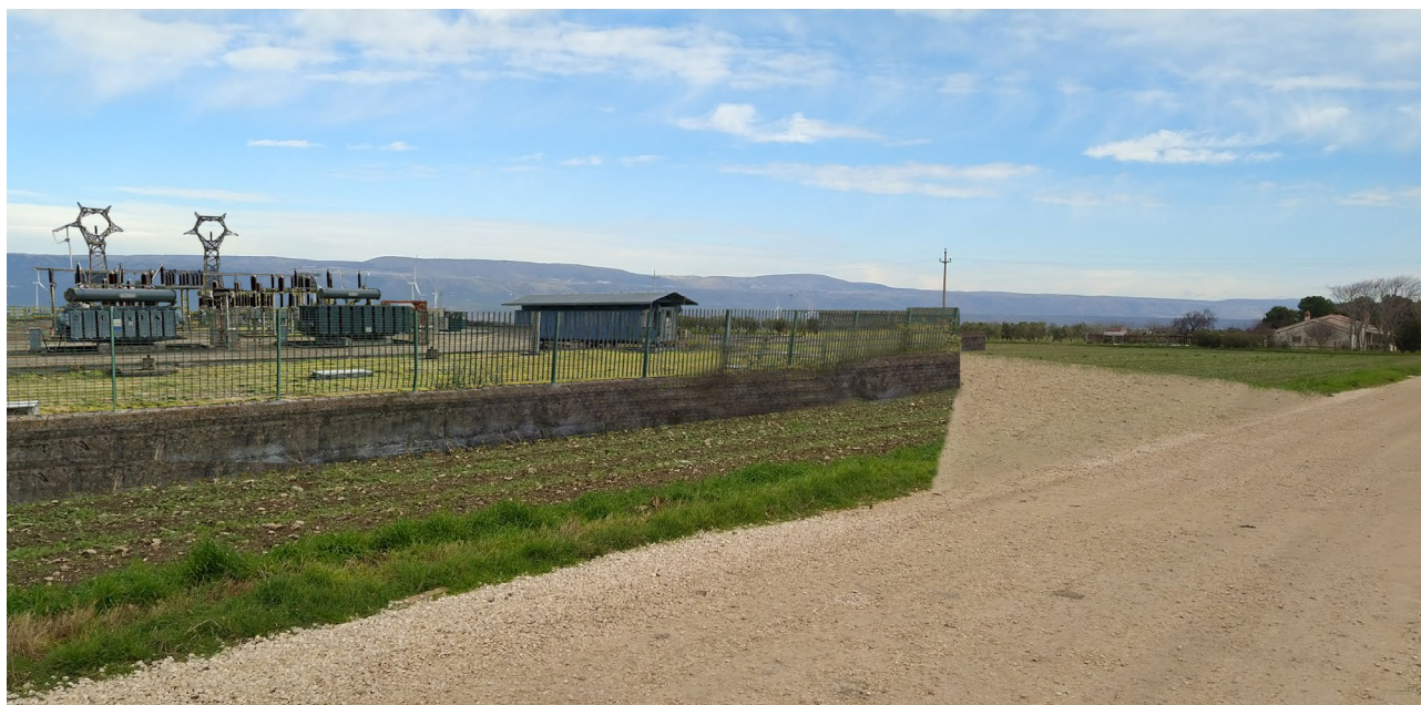
Punto di vista 10. Foto – inserimento della Cabina Primaria AT/MT Foggia – Amendola.
