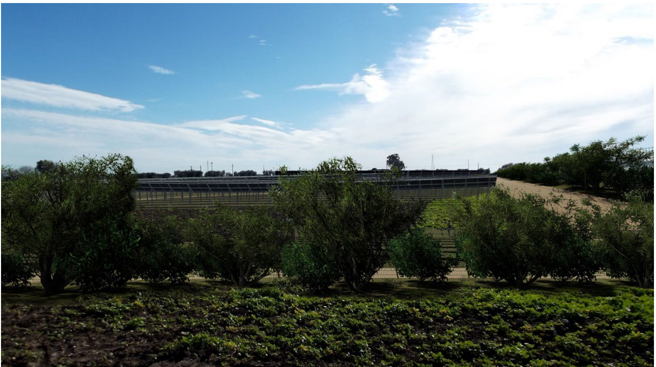
Punto di vista dal confine nord del lotto dopo l'installazione dell'impianto.
