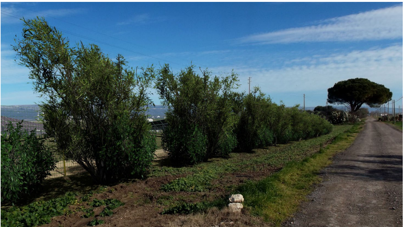
Punto di vista dalla strada vicinale di ingresso verso il lotto dopo l'installazione dell'impianto.
