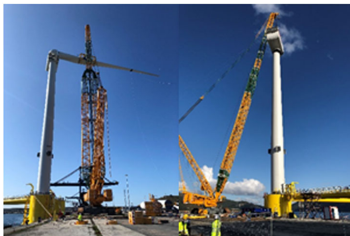
Figura 2.8 Installazione della turbina eolica
