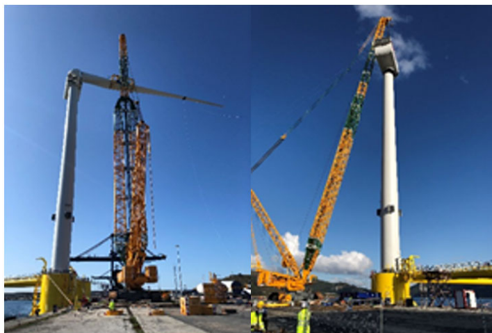
Figura 2.7 Installazione della turbina eolica
