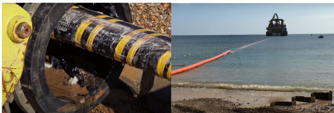
Figura 2.10 Inserimento di un cavo export offshore sulla riva.
