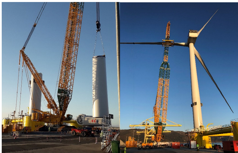
Figura 2.24 Installazione della torre e della turbina
