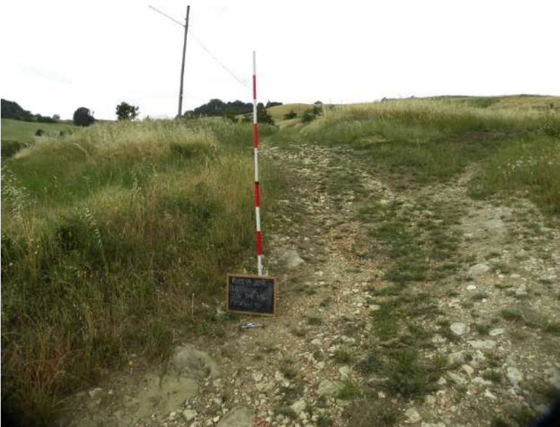
Figura 37. Cavidotto esterno: Loc. Iane.
