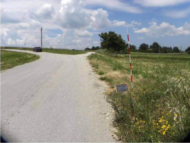
Figura 22. Cavidotto –viabilità WTG 03-06.
