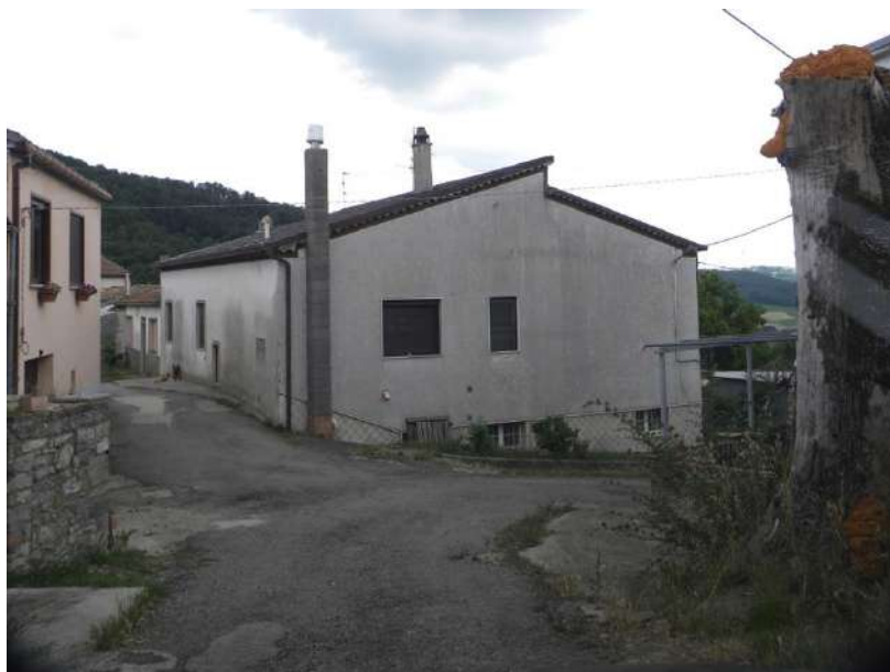
Figura 38. Cavidotto esterno: Loc. Iane.
