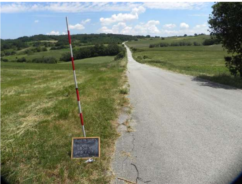
Figura 23. Cavidotto –viabilità WTG 03-04-06.
