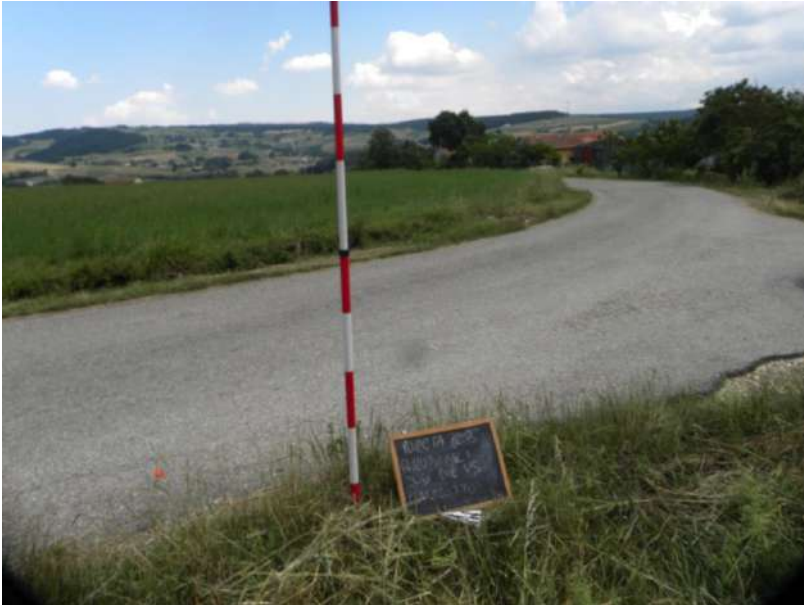
Figura 44. Cavidotto esterno: contrada Casalicchio.
