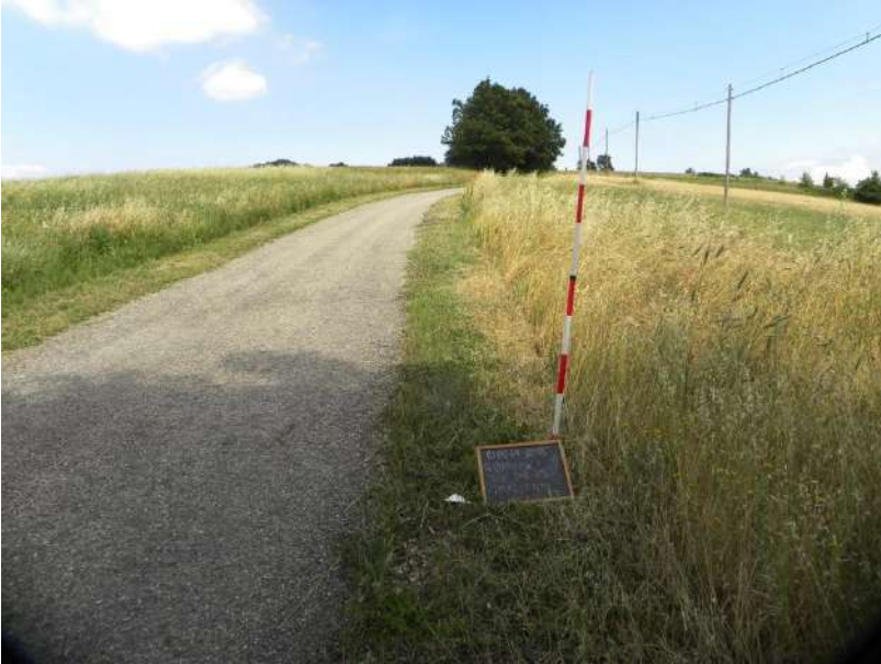
Figura 46. Cavidotto esterno: contrada Iane.
