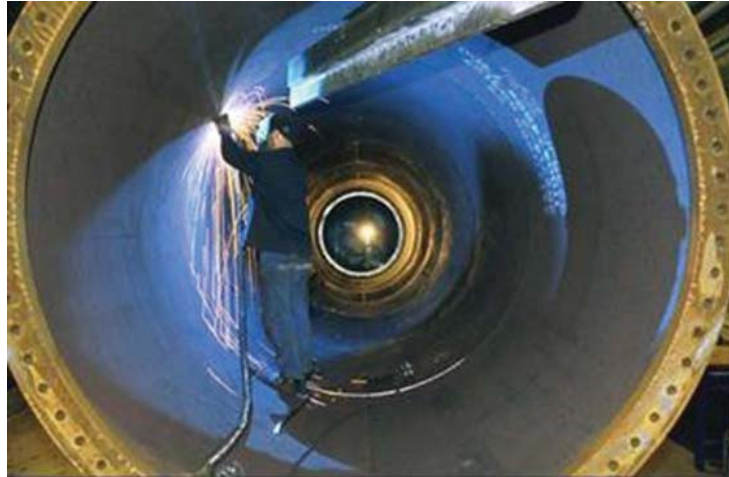
Figura 11: Interno di una torre
