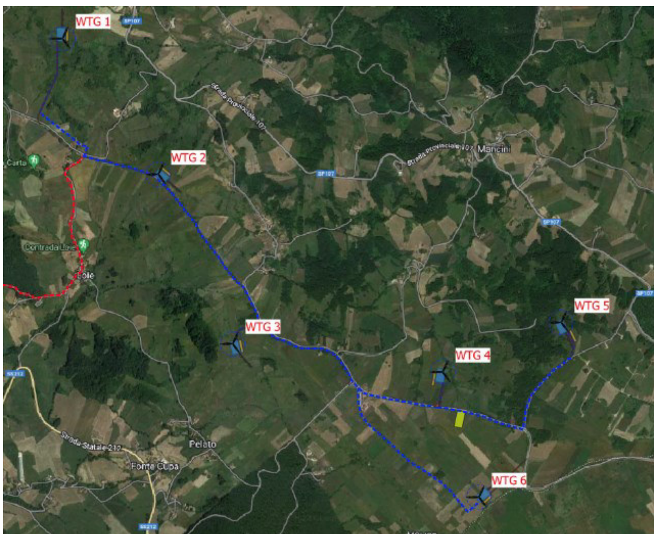
Figura 5 – Viabilità esistente di accesso agli aerogeneratori
