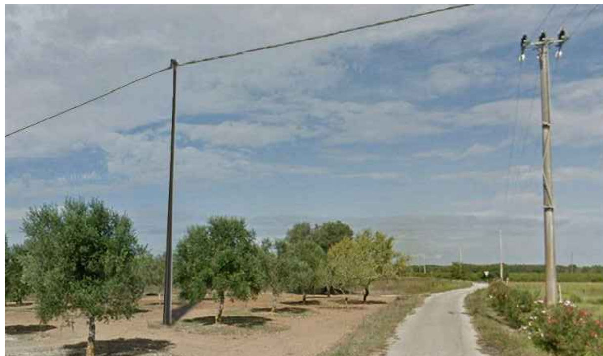
FOTO 3 VISTA CON INSERIMENTO SUPPORTI
