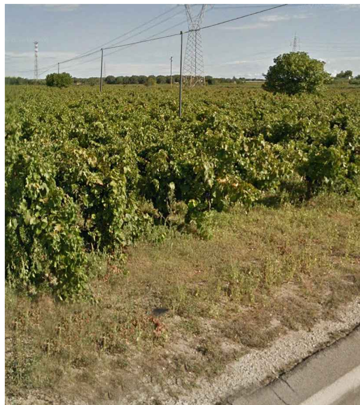
FOTO 5 VISTA CON INSERIMENTO SUPPORTI
