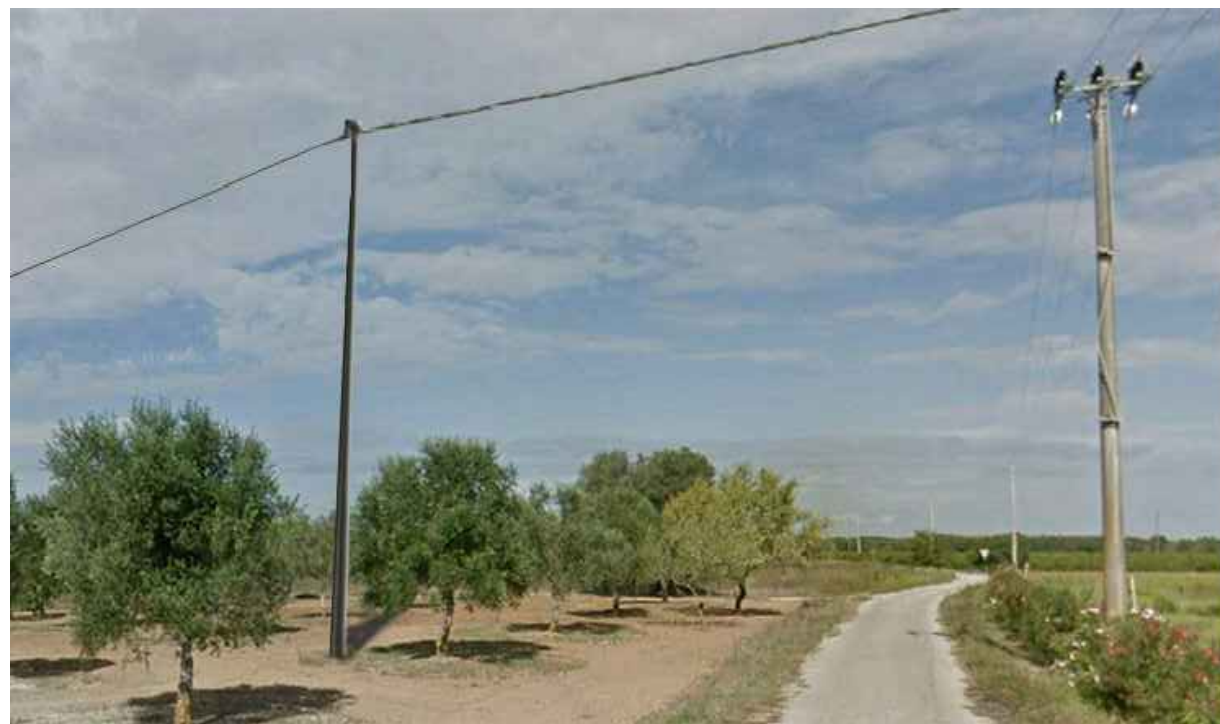
FOTO 3 VISTA CON INSERIMENTO SUPPORTI
