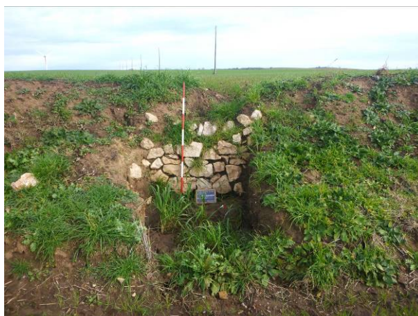
Fig. 40. Campo FV 1, muro di terrazzamento parzialmente coperto dalla vegetazione, vista da S.
