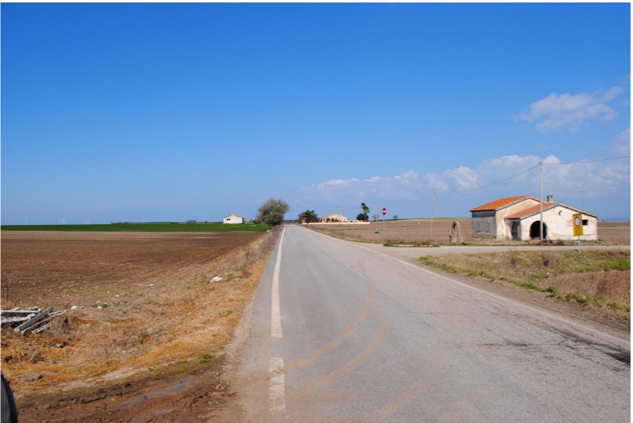
Foto 9: Strada provinciale 31 (SP31) interessata dal passaggio del cavidotto.
