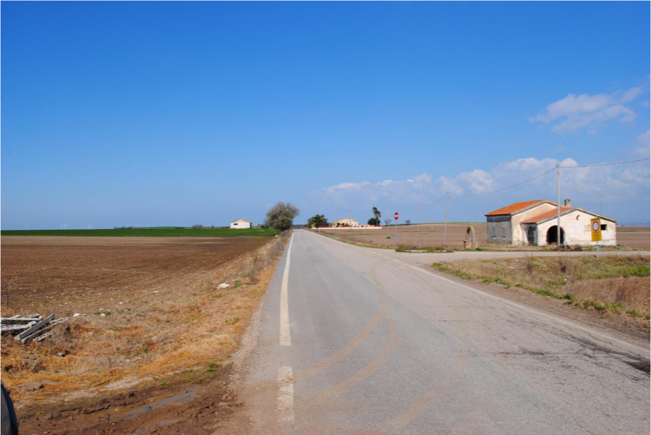
Foto 11: Strada provinciale 31 (SP31) interessata dalla realizzazione del cavidotto.
