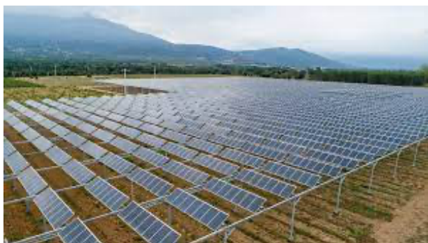
Zona di intervento
