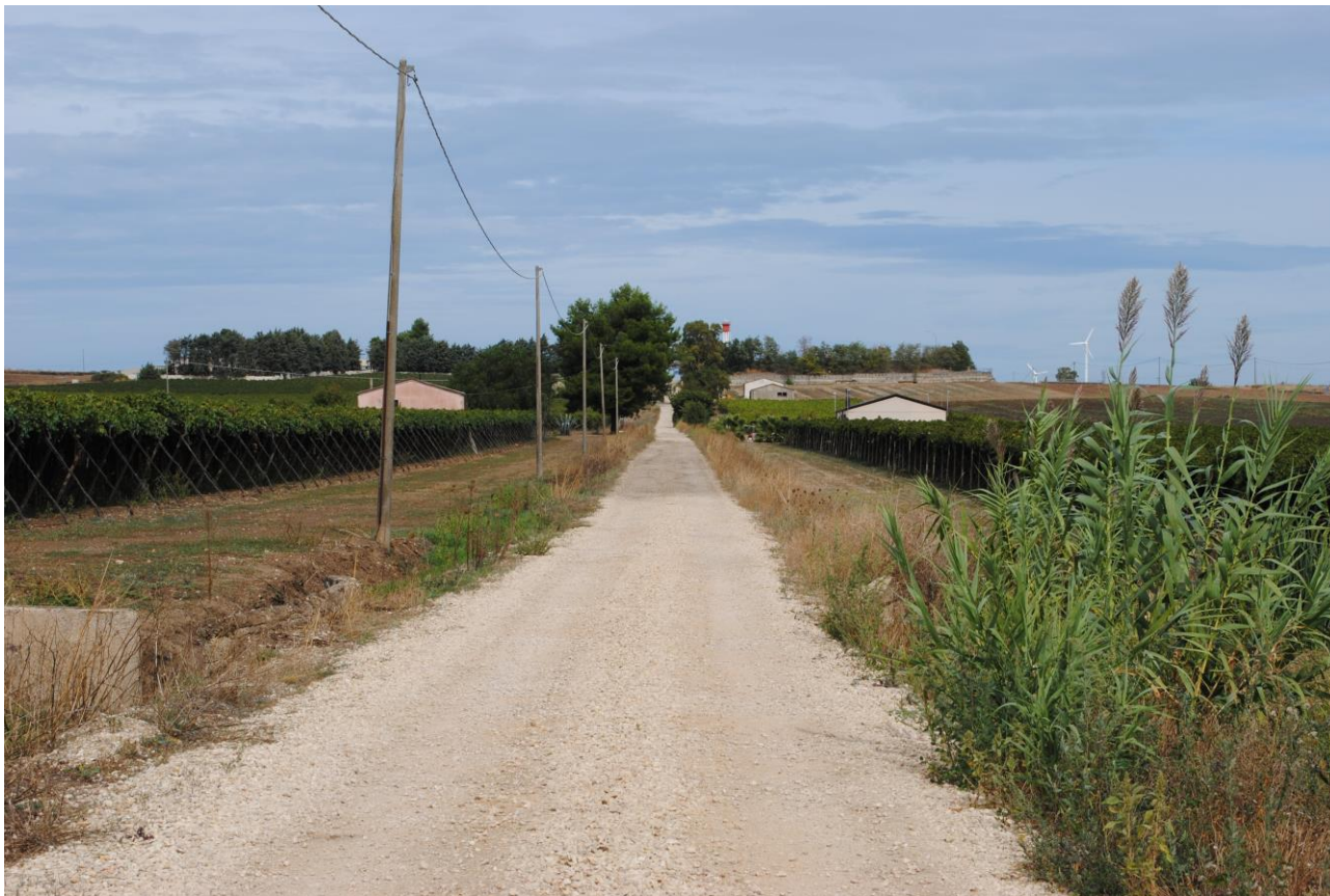
Foto 7: Foto relativa alla strada secondaria che sarà interessata dal passaggio del cavidotto diretto al condominio.
