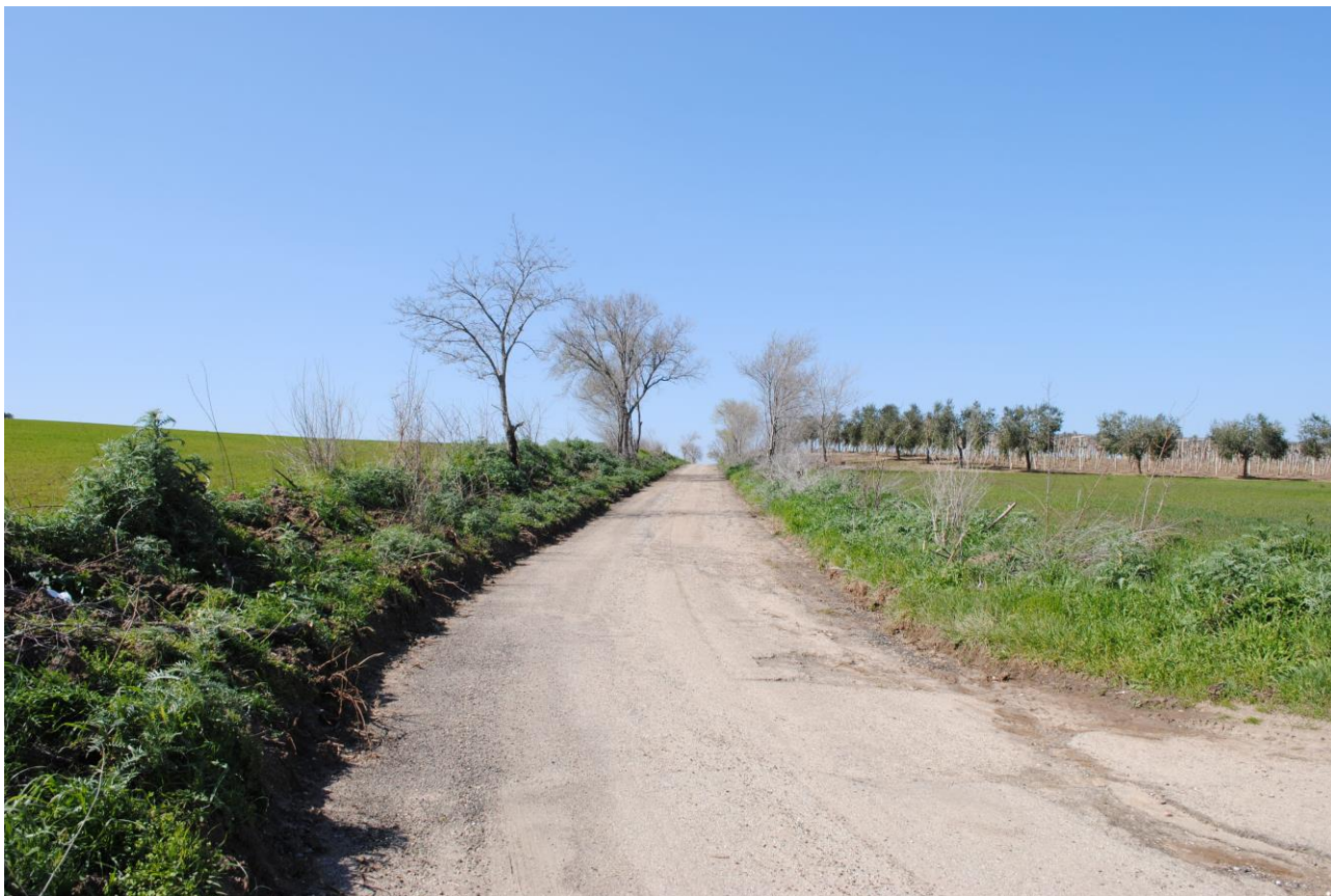
Foto 12: Punto F10, Strada provinciale 39.
