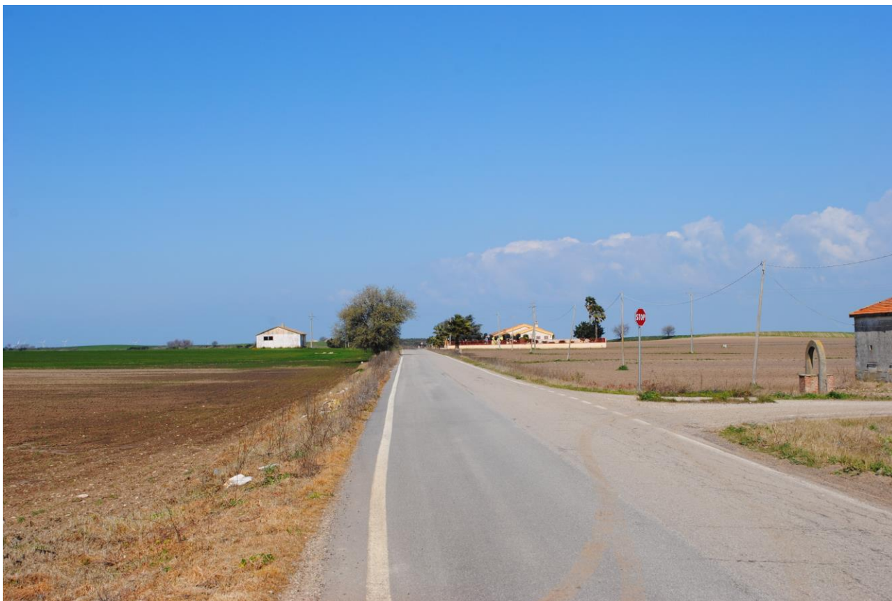
Foto 13: Punto F11, strada provinciale 31 (SP31).
