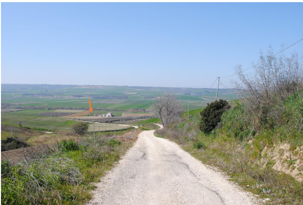
Foto 16: Punto F12, la freccia indica il tratto di passaggio del cavidotto nei pressi di un vigneto.
