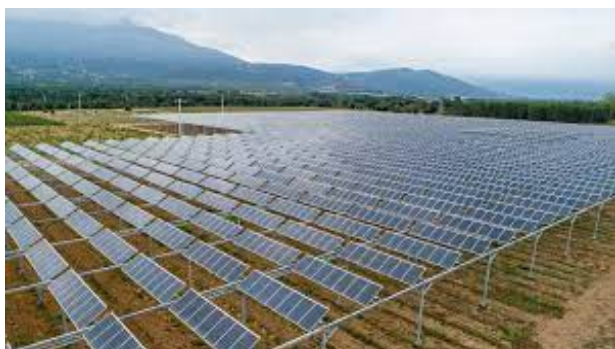
Zona di intervento
