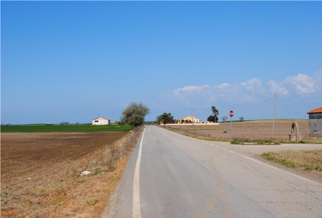
Foto 7: Punto F11, strada provinciale 31 (SP31).
