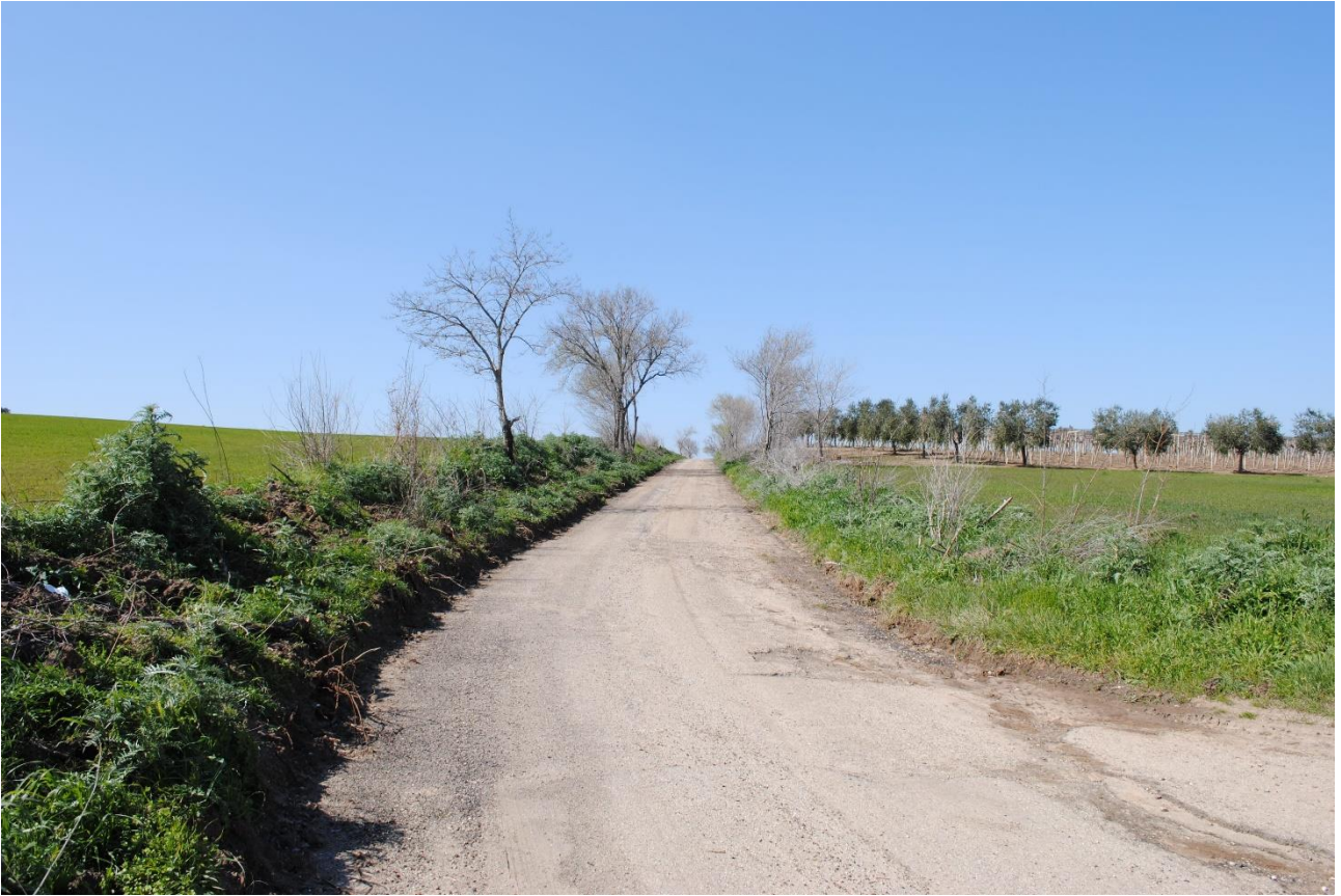
Foto 32: Punto F10, Strada provinciale 39.
