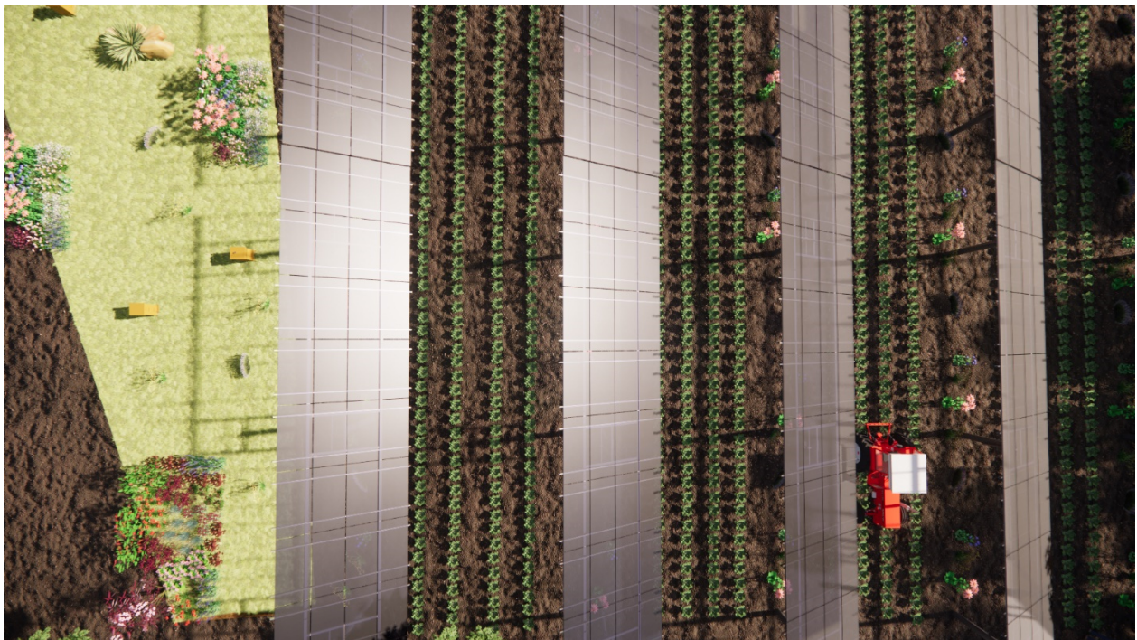
Figura 3-4 Vista interna di impianto agrivoltaico tipo di progetto (3/3)
