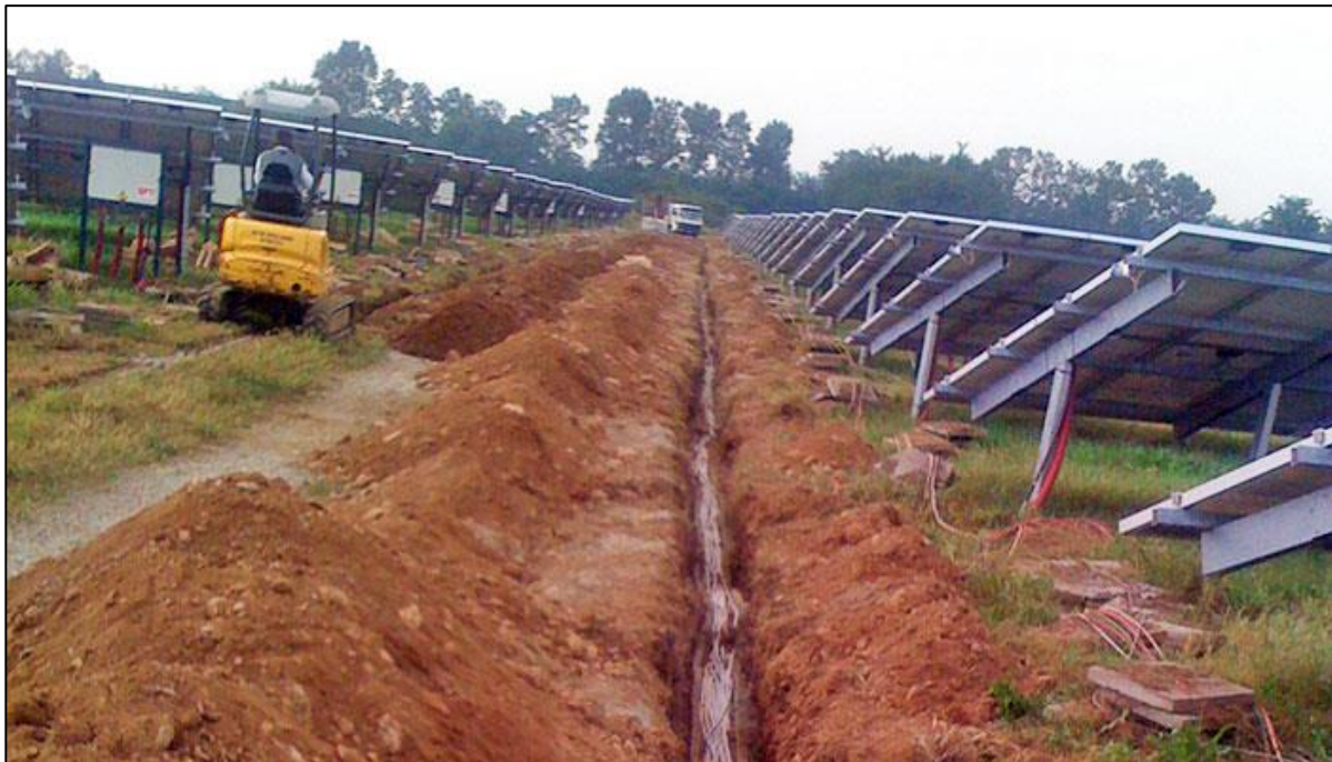
Figura 17 – Tipico di scavo per cavi BT/MT
