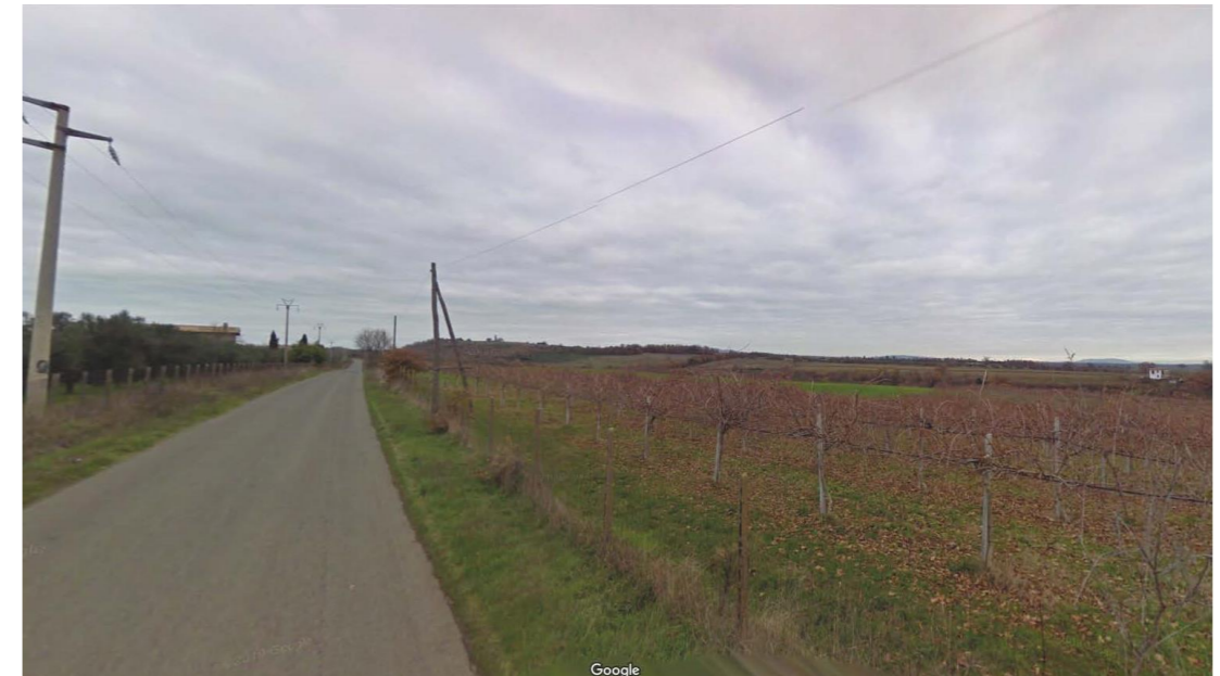
Figure 5 Punto di vista nr 3 – Strada Trinità, Viterbo (VT) - Stato di fatto
