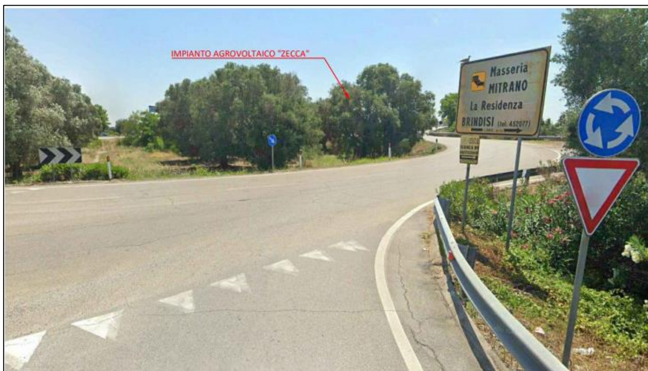
Figura 20: FOTO 4 POST OPERAM
