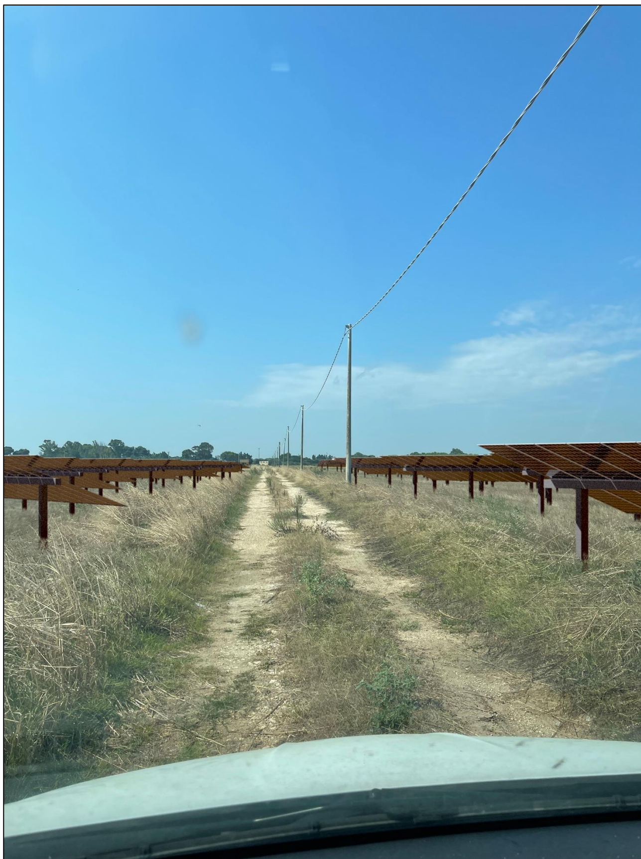
Figura 18: FOTO 2 POST OPERAM
