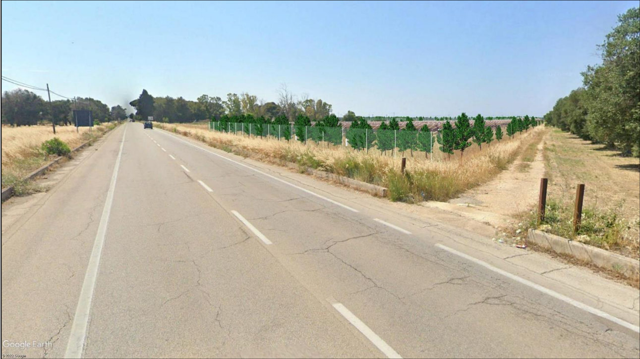
Figura 17: FOTO 1 POST OPERAM
