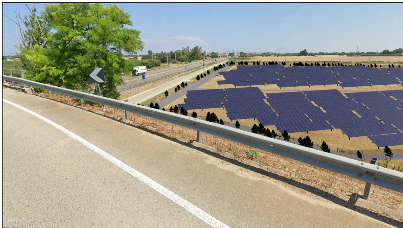
Figura 19: FOTO 3 POST OPERAM
