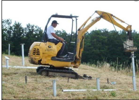
**Figura 3: Sistema di ancoraggio al suolo denominato "T-Block"**
