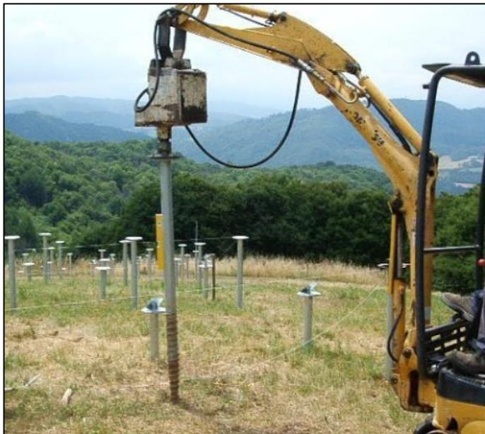
**Figura 2: Modalità fissaggio tracker**
