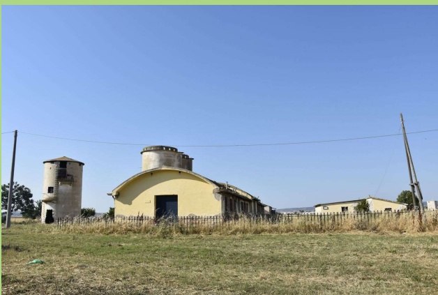
Foto 25. Podere Camilli, all'interno della zona "D" industriale.
