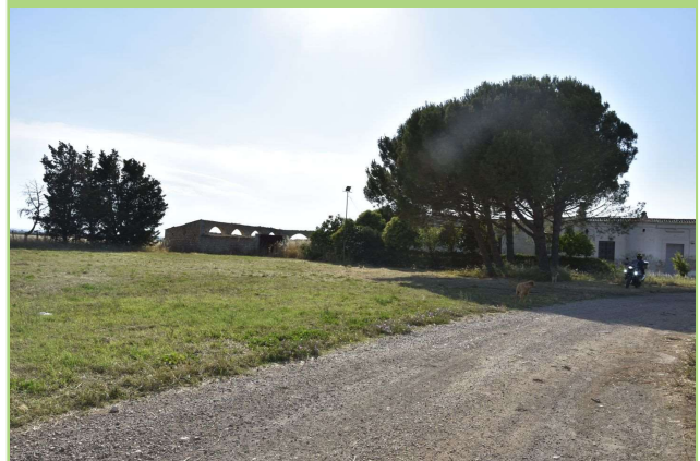
Foto 26. Podere Camilli, all'interno della zona "D" industriale.
