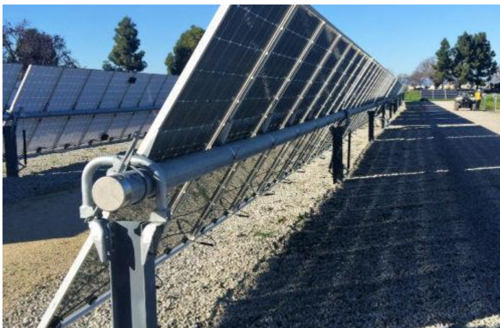
Figura 4.3: Esempio di struttura a tracker monoassiale
