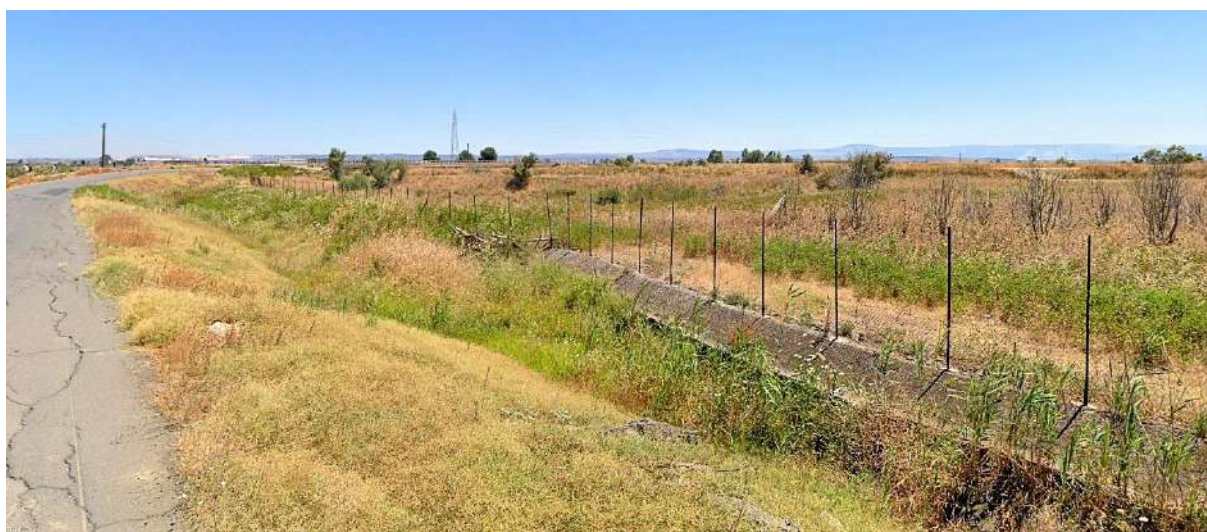
Figura 5.102: Vista 2 – Stato di fatto
