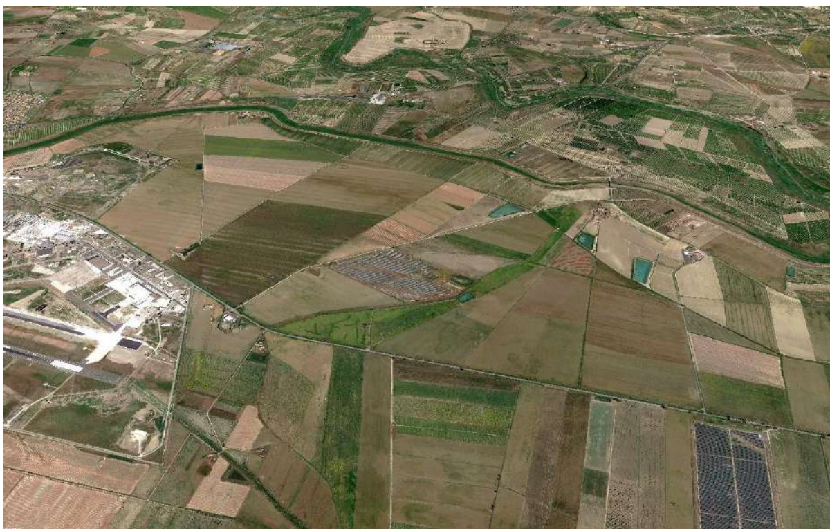
Figura 5.97: Vista aerea– Stato di fatto
