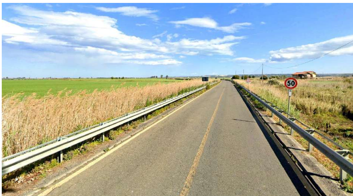
Figura 5.104: Vista 3 – Stato di fatto
