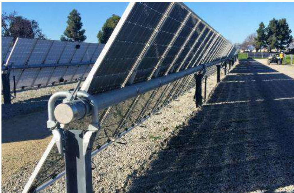
Figura 3.4: Esempio di struttura a tracker monoassiale
