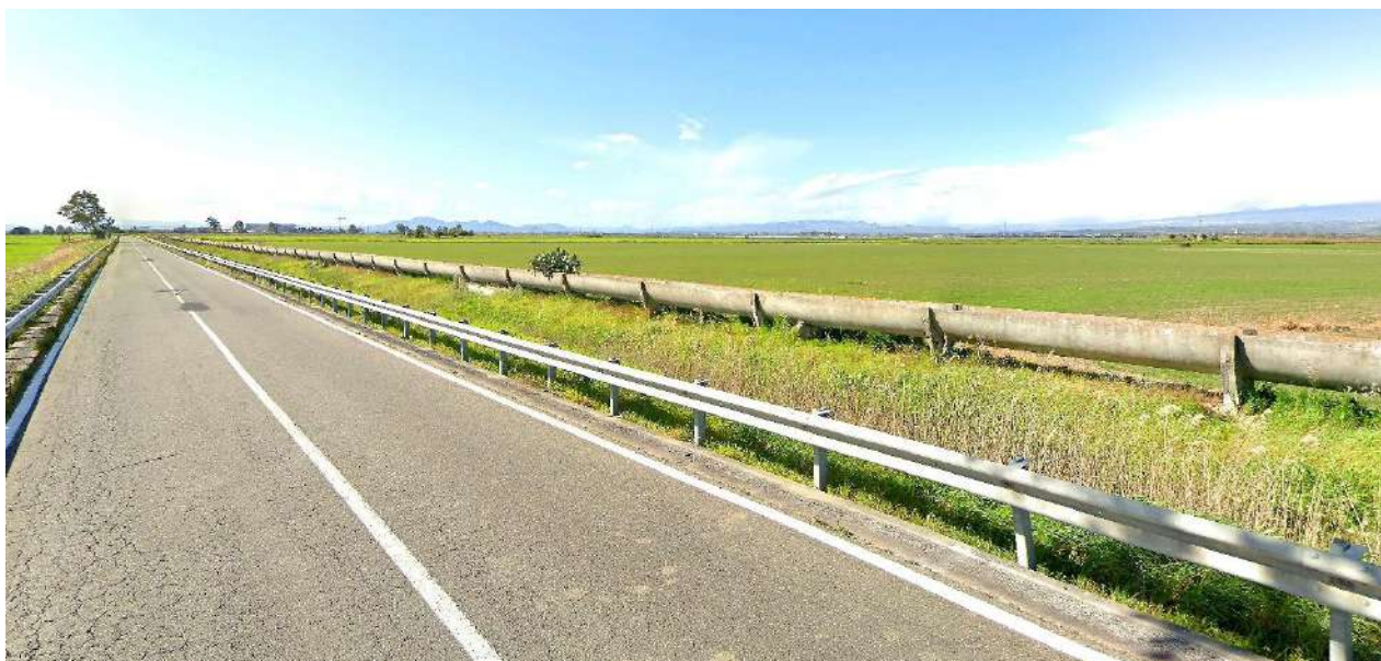
Figura 5.100: Vista 1 – Stato di fatto
