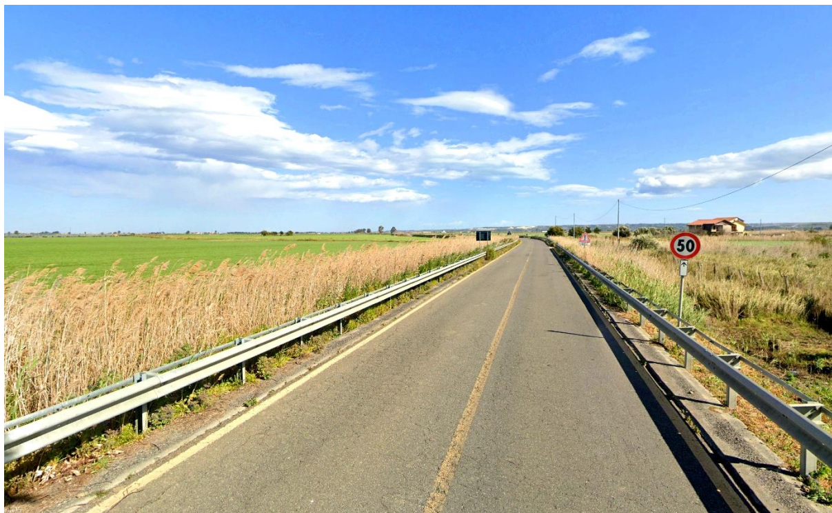
Figura 5.10: Vista 3 – Stato di fatto
