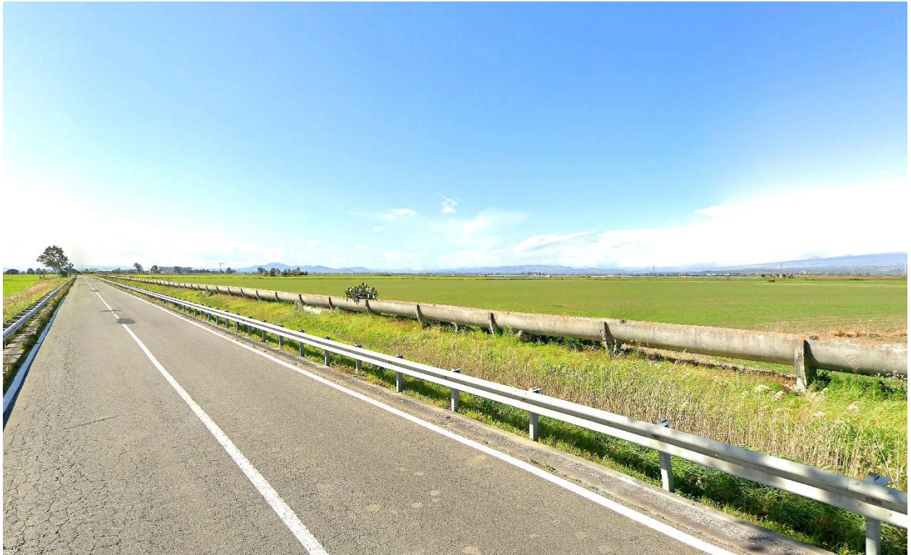
Figura 5.6: Vista 1 – Stato di fatto
