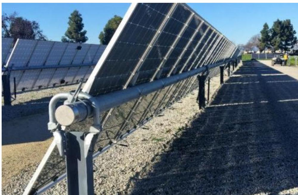
Figura 5.2: Esempio di struttura a tracker monoassiale
