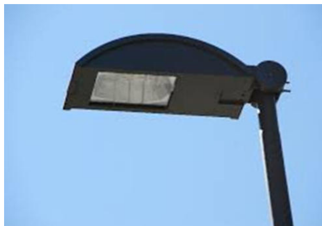
Figura 5.5: Esempio di apparecchio completamente schermato (full-cut-off).
