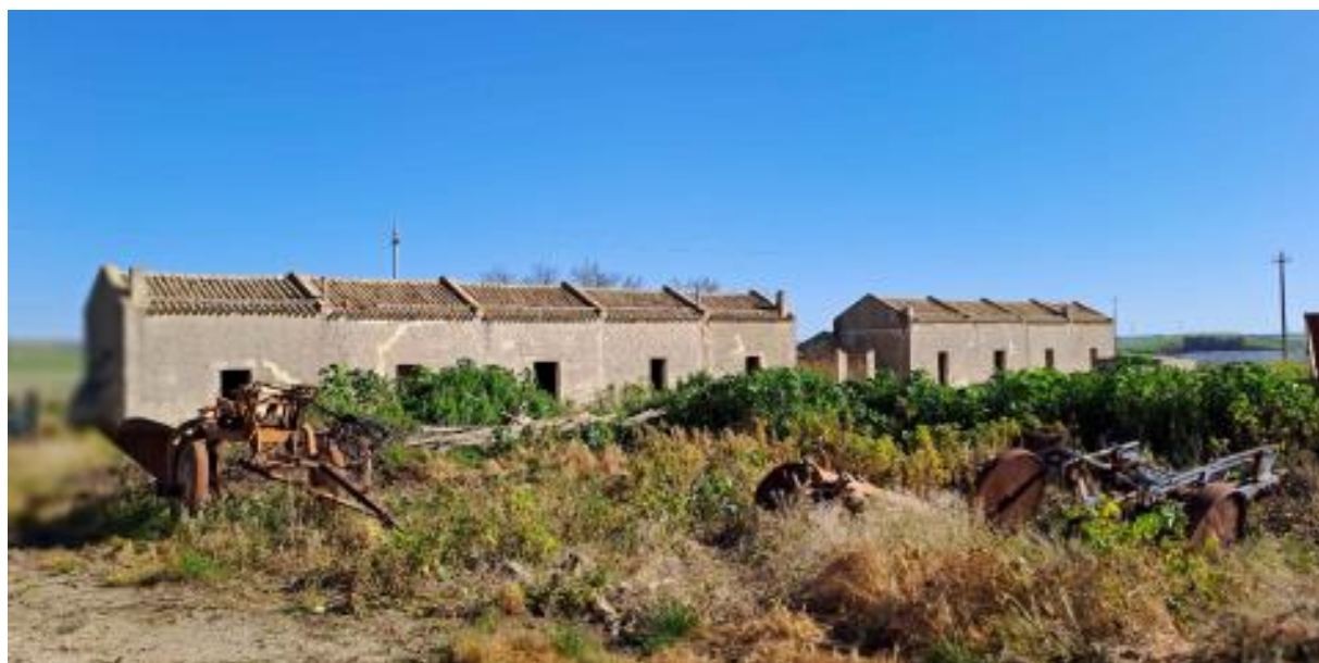
Figura 8-14 – Esempio ruderi da demolire
