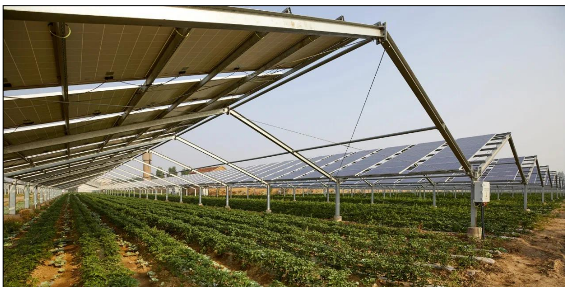
Figura 9-2 – Agrivoltaico a moduli fissi con struttura a falde in Cina, in un campo coltivato a bacche di Goji
