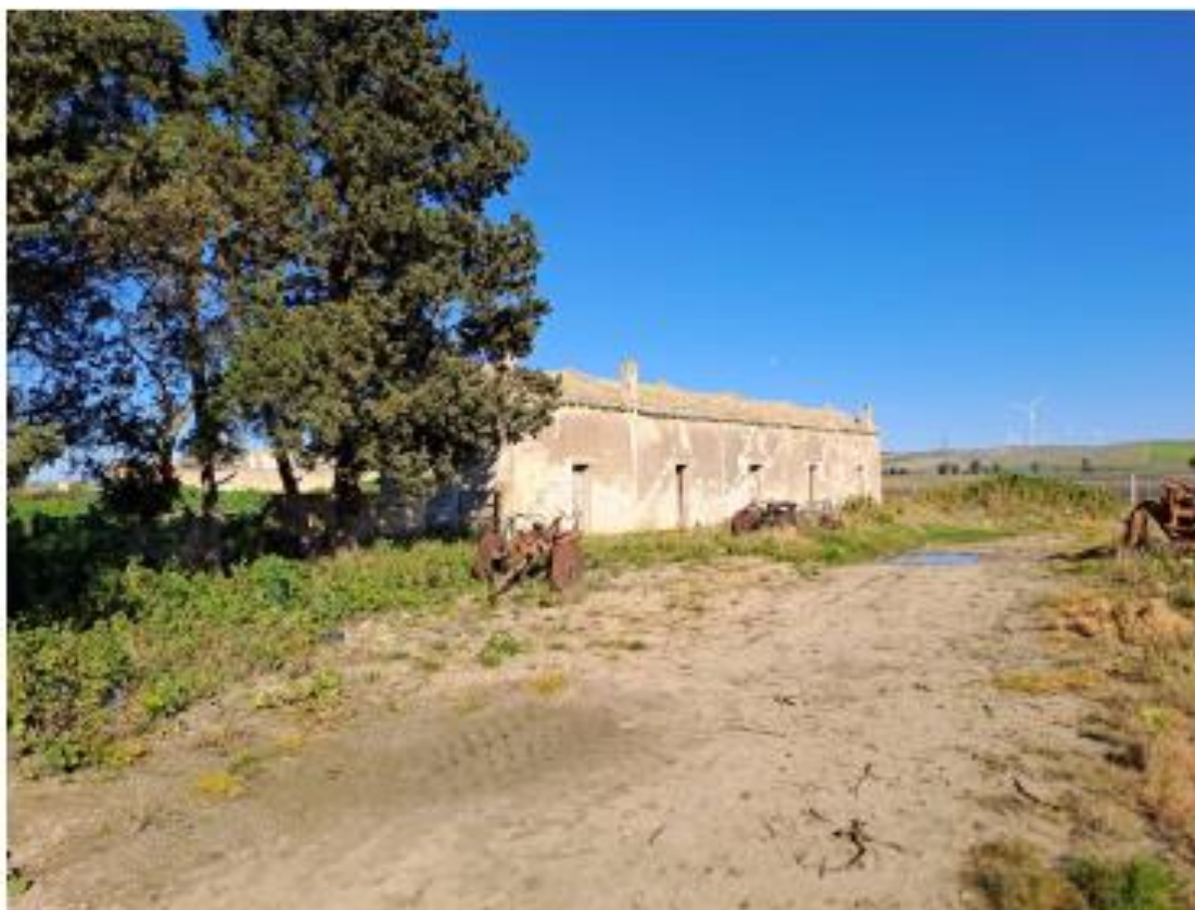
Figura 4-5 – Rudere da demolire 4
