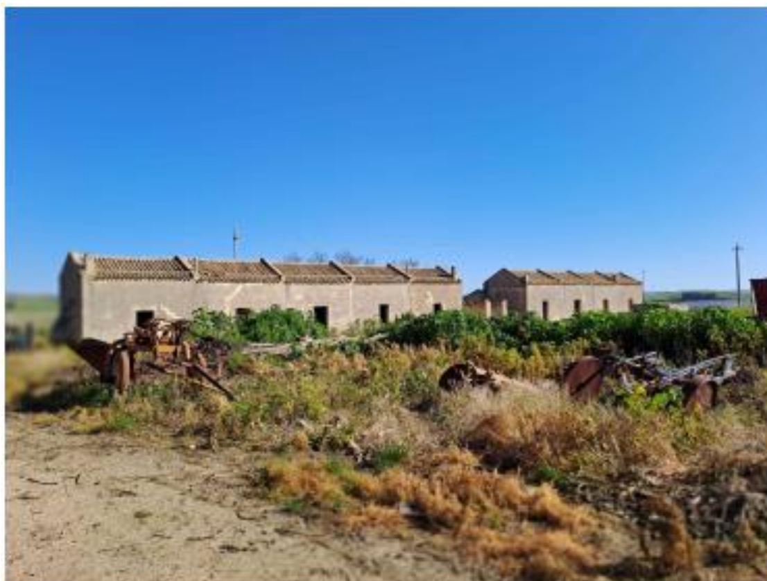
Figura 4-6 – Ruleri da demolire 5 e 6
