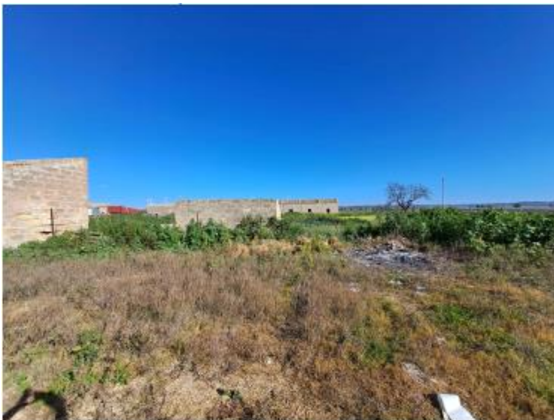
Figura 4-8 – Ruederi da demolire 4, 7 e 9
