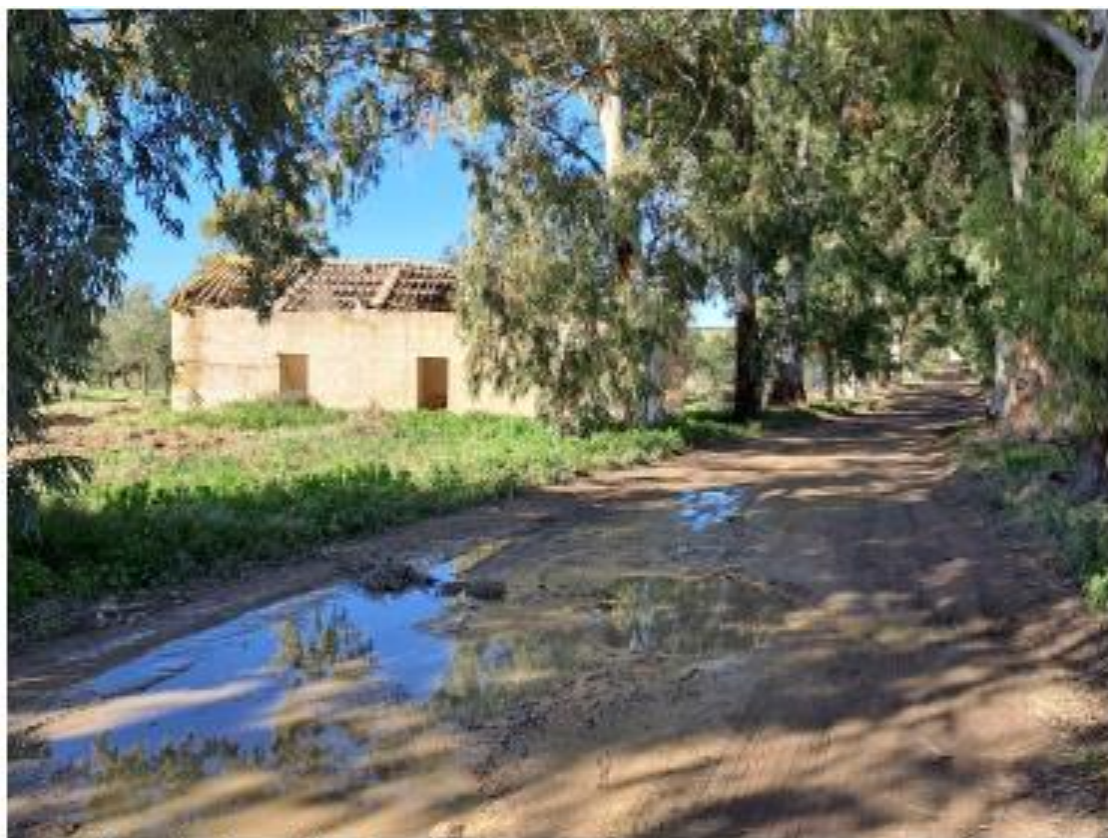
Figura 4-2 – Rudere da demolire 1
