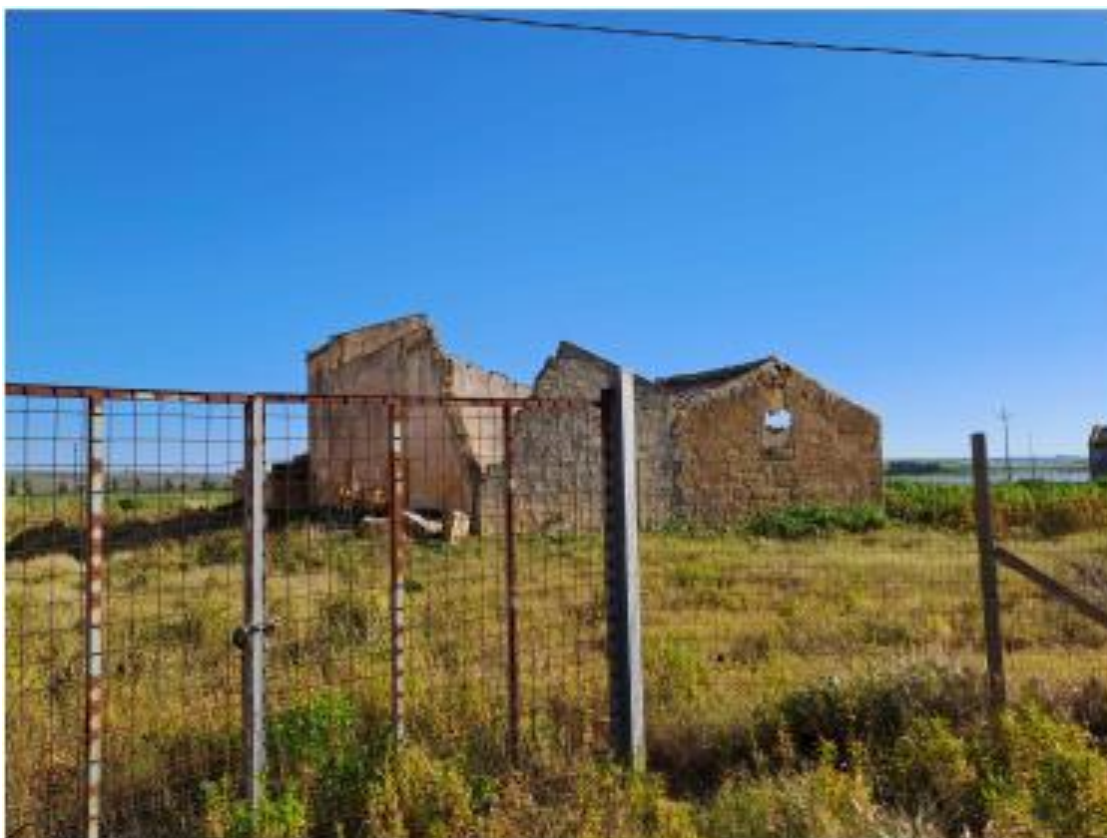
Figura 4-4 – Rudere da demolire 3
