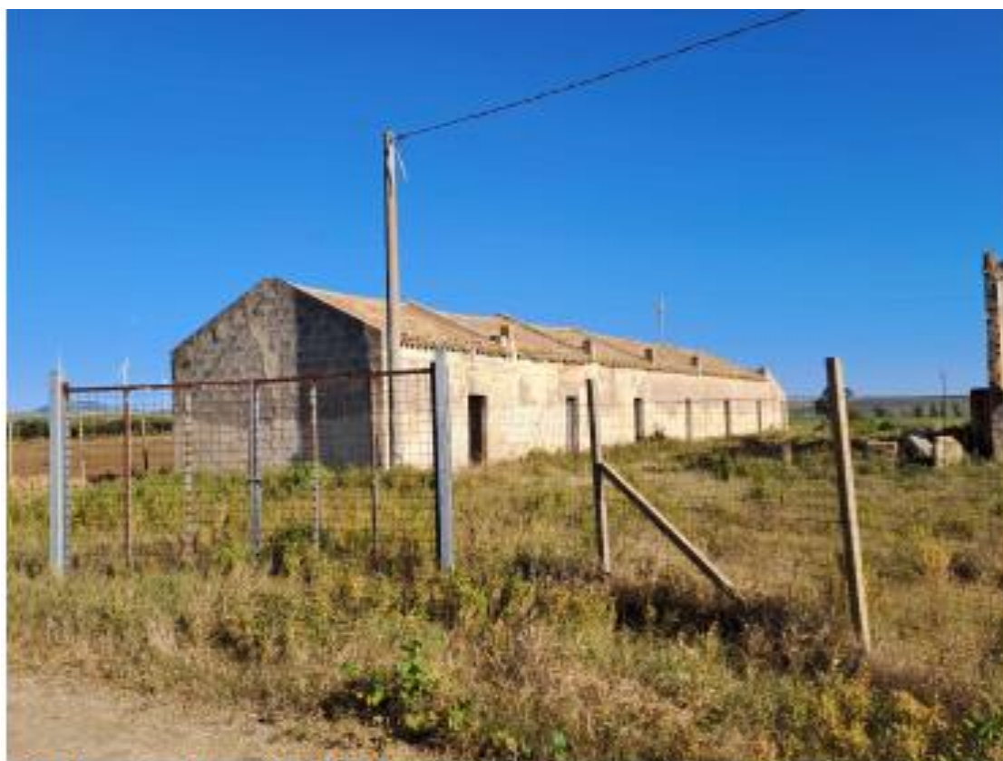
Figura 4-3 – Rudere da demolire 2
