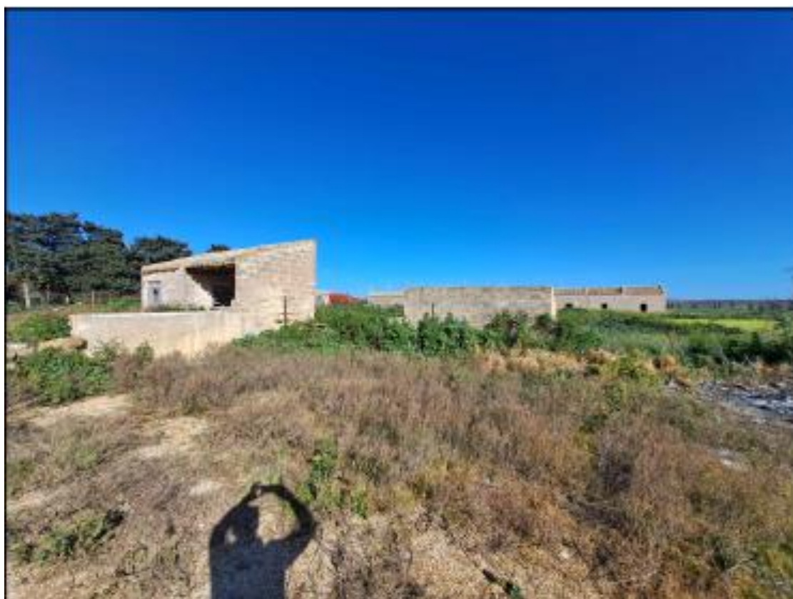
Figura 4-7 – Ruleri da demolire 7 e 8
