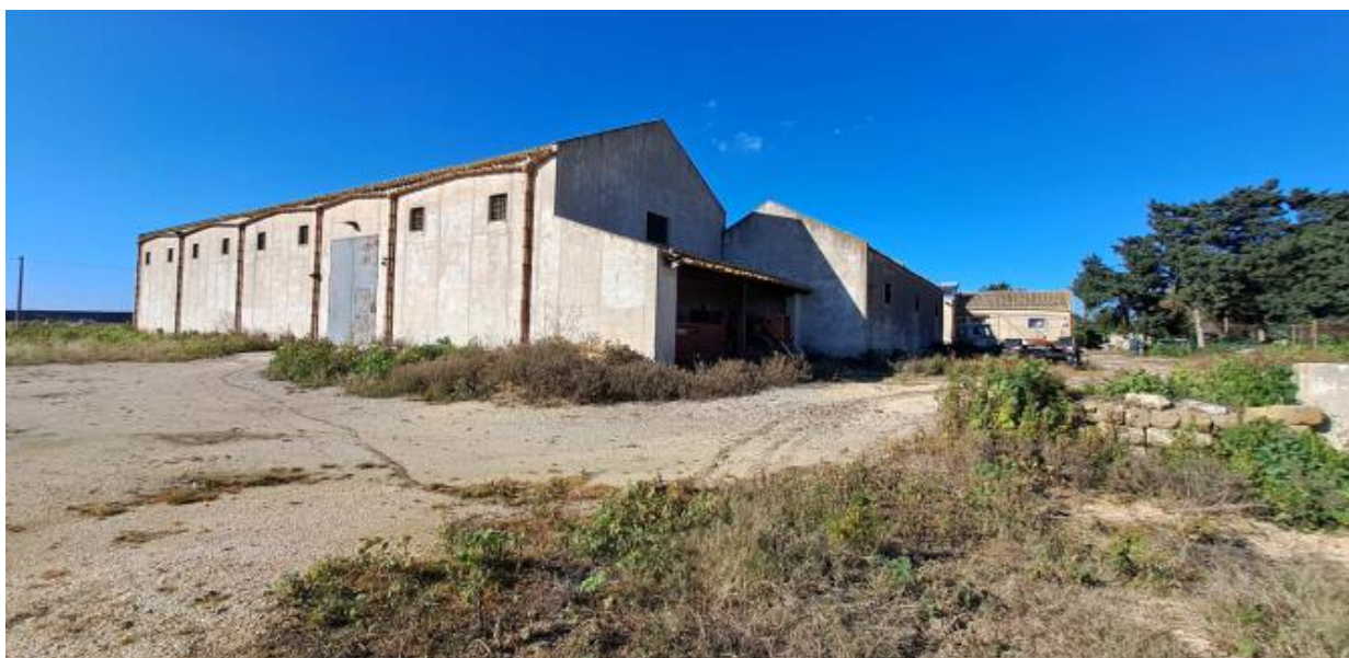
Figura 4-2 – Riqualificazione casolare – Stato di fatto
