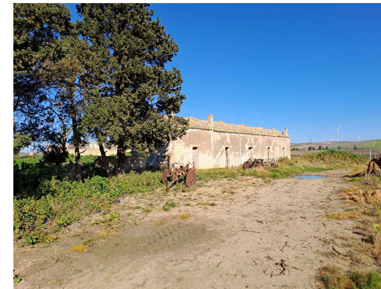
Rudere da demolire 4
