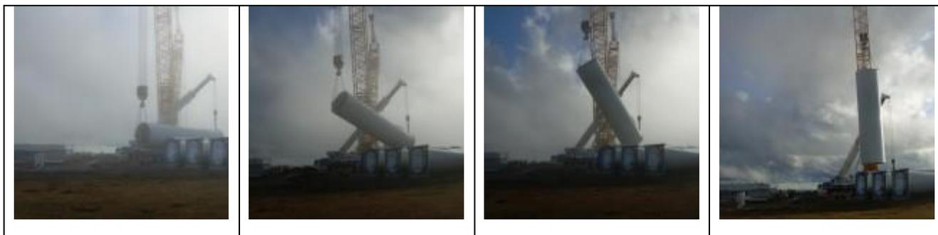
Figura 5.38 – Schema delle fasi di sollevamento dei componenti dell'aerogeneratore (Fonte sito web <http://www.windfarmbop.com/> )
