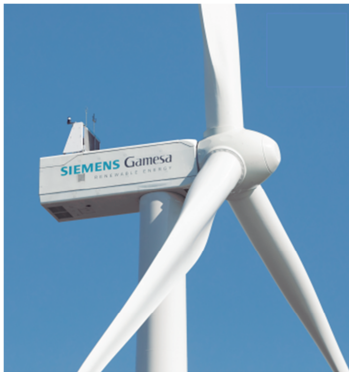
Figura 4.1 – Aerogeneratore Siemens-Gamesa tipo SG 6.6-170
