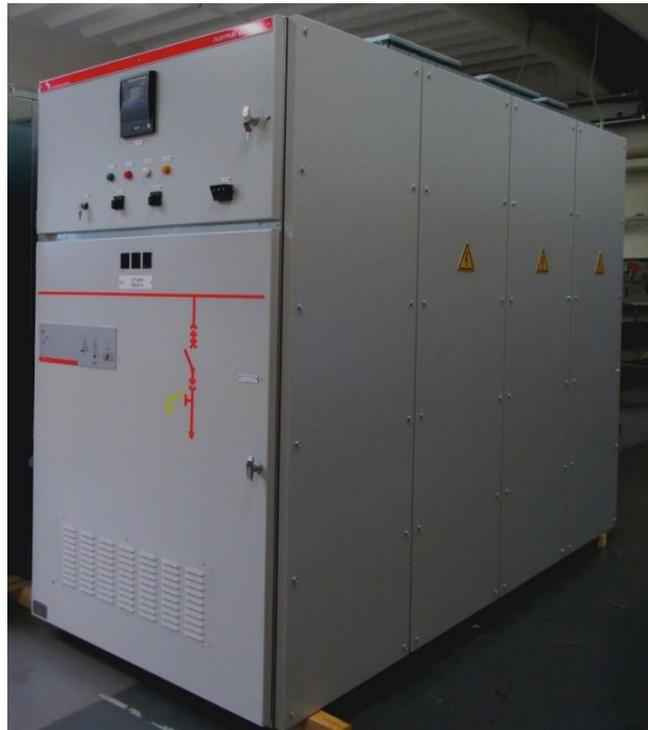
*Figura 2.3 – Stallo 36kV per connessione produttore*
