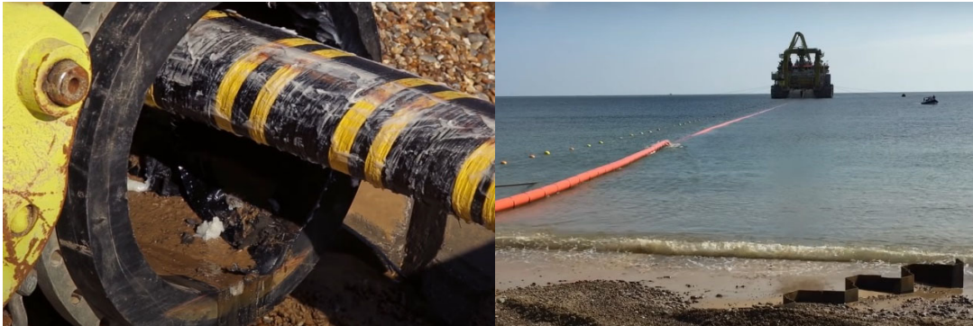
Figura 4.17 Inserimento di un cavo export offshore sulla riva
