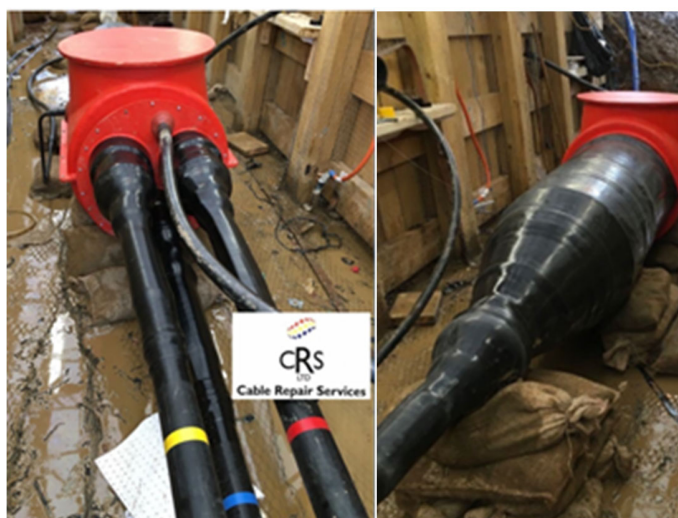
Figura 4.14 Giuntura di transizione sulla terraferma
