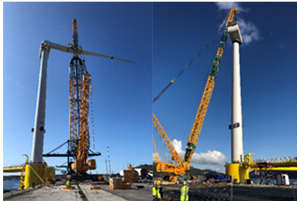
Figura 4.9 Installazione della turbina eolica
