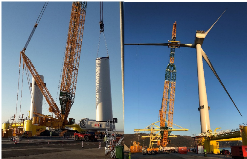
Figura 6.3 Installazione della torre e della turbina
