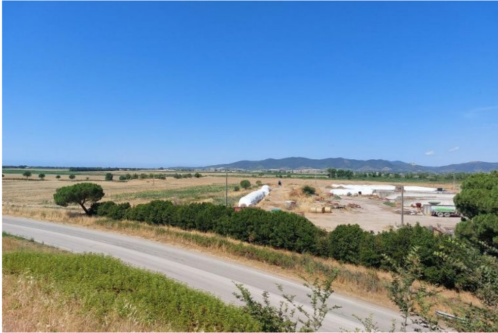
Figura 40 Visuale 6 ante operam dal viadotto della SP152.
