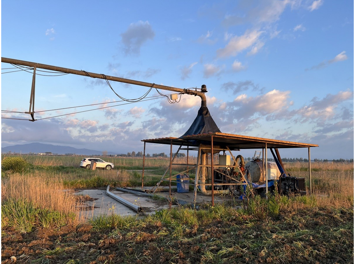
Figura 8-Struttura centrale del sistema di irrigazione con fondazione di cemento
