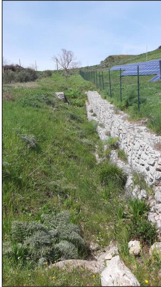
Figura 10 – Particolare impluvio esistente con gabbionate negli argini
