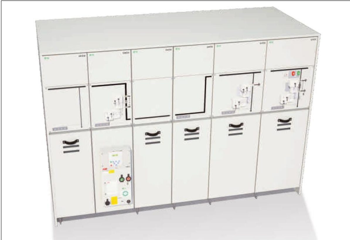
Figura 24: esempio tipico di quadro elettrico di MT
