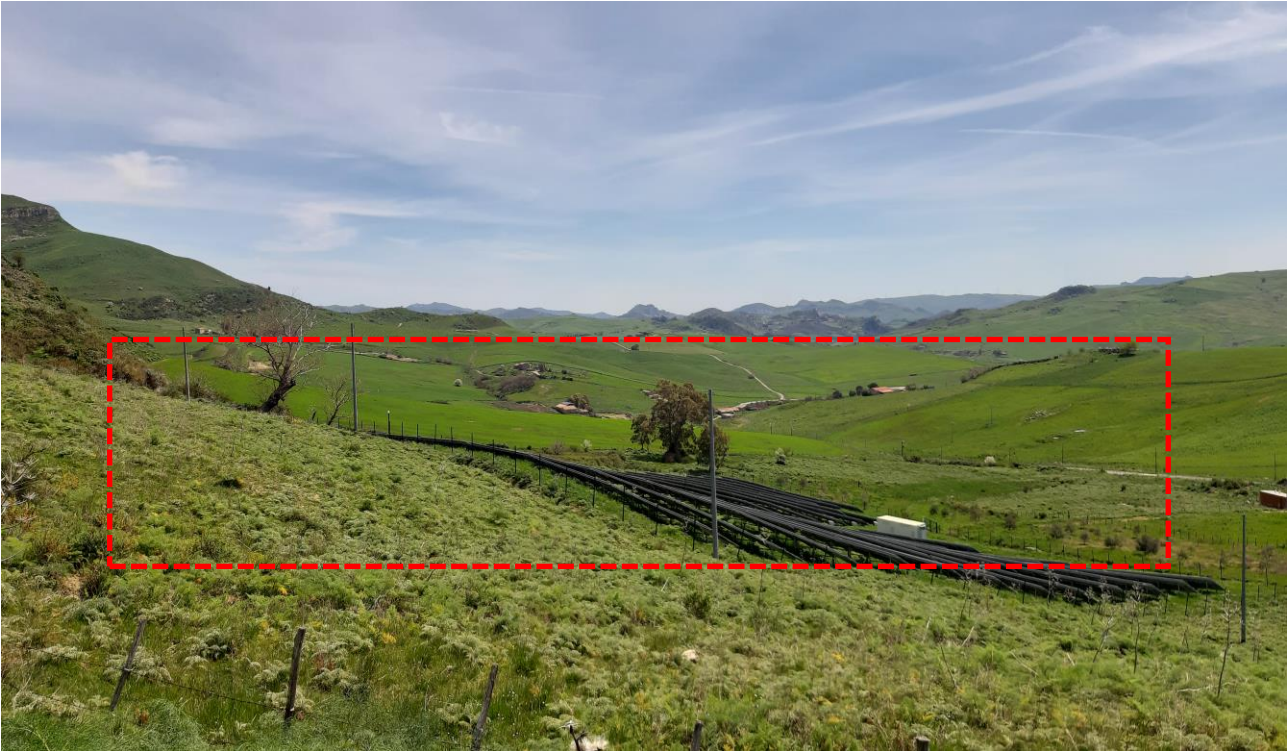
Figura 12 – Strada adiacente a ovest dell’impianto
