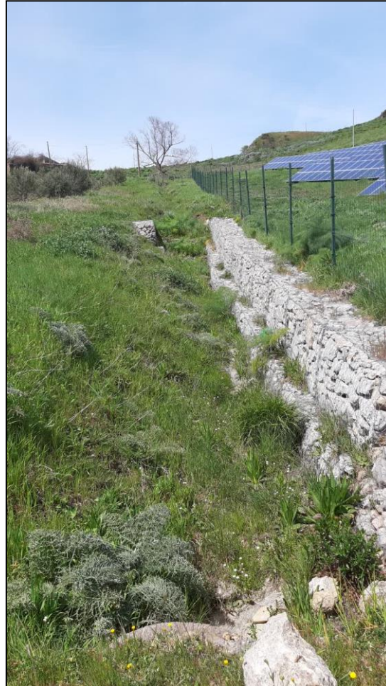
Figura 11 – Particolare impluvio esistente con gabbionate negli argini
