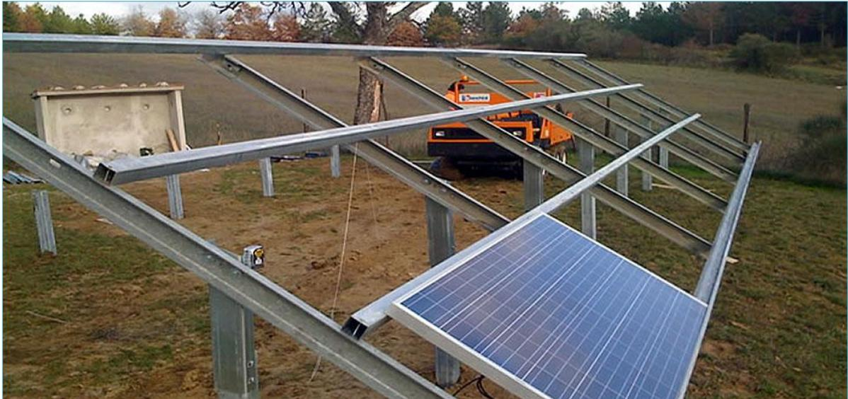
Figura 32 – Montaggio strutture di sostegno
